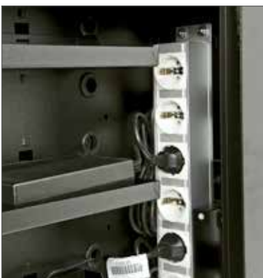
Bandeau d'alimentation à démarrage par palier.
